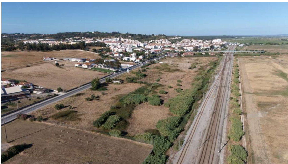
Figura 6. Perspetiva geral da área do PP Azambuja Poente na direção do centro urbano da vila
