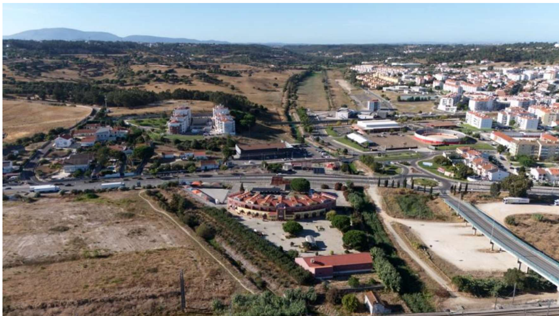
Figura 7. Zona de contacto entre o PP e a área consolidada da vila, com o hotel Ouro Negro no centro da imagem.
