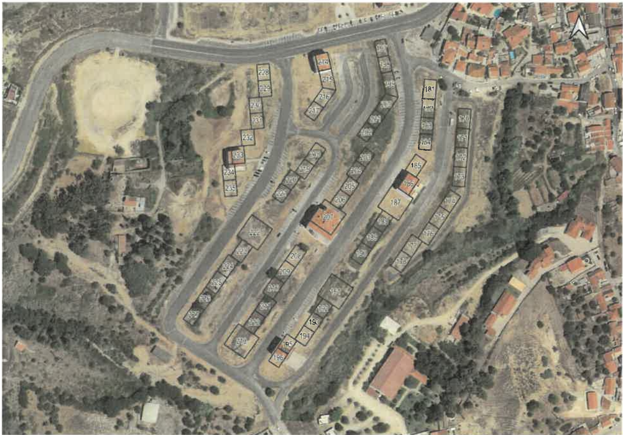
Figura 2. Identificação dos “lotes” 170 a 235
